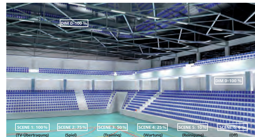
Bei einem DALI-Beleuchtungssystem können verschiedene Beleuchtungsszenarien voreingestellt und verwendet werden. So lässt sich bspw. die benötigte Lichtintensität für einen ausgewählten Hallenbereich voreinstellen. Innerhalb eines Beleuchtungsszenarios können alle Leuchten an jedes Lichtstromniveau angepasst werden (Dimm-Funktion). Diese Beleuchtungsszenarien können einfach über Steuerungstasten oder über einen Computer ausgewählt werden.
