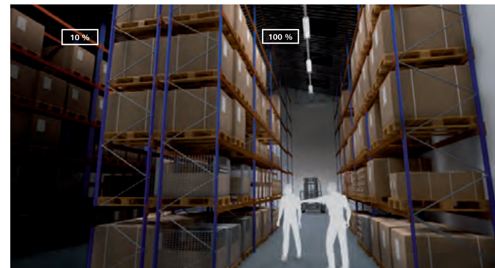
Wenn nicht genug Tageslicht vorhanden ist und der Sensor im entsprechenden Lagerbereich eine Bewegung erfasst, leuchten die Lampen mit einer (voreingestellten) maximalen Lichtstärke für den jeweiligen Raum (den jeweiligen Gang). Der übrige Bereich des Lagers wird auf Sicherheitsniveau, z. B. 10%, beleuchtet.
