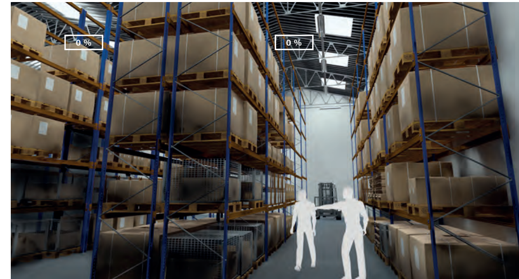
Wenn in Regalgängen eine Bewegung erfasst wird, jedoch durch die Oberlichter genug Sonnenlicht hereinströmt, schalten sich die Leuchten nicht ein. Sie bleiben aus und senken so den Energieverbrauch.
