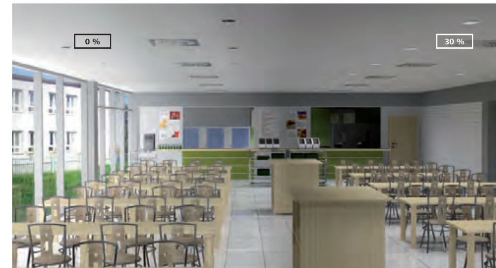
Die Schiebescalter ermöglichen das Einstellen jedes beliebigen Lichtstrom-Levels für jede Leuchtengruppe. Hierfür kann man auch die Leuchten in Fensternähe und die im Rauminnen in ein Verhältnis setzen (die sogenannte Offset-Funktion).
