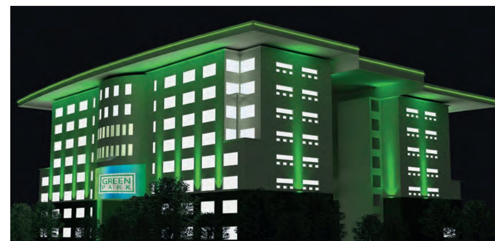
Zur Erhöhung der Beleuchtung des Gebäudes wird die Frontwand mit LED-Panels ausgestattet. Videos werden über einen Videokonverter in das System eingespeist.
