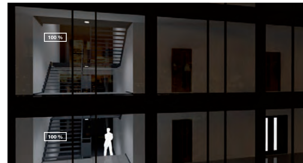
Wenn eine Person in den Keller geht, wird auch dort die Bewegung erfasst. Und wenn diese Person für längere Zeit dort bleibt, gehen die Lampen über dem Erdgeschoss aus. Der Kellerbereich hat ein eigenes Beleuchtungssystem.
