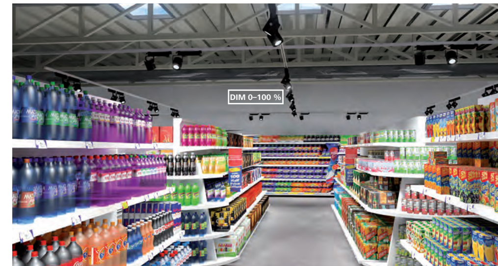
Die Möglichkeit, einen Lichtintensitätssensor anzuschließen, bedeutet, dass das CPS auch die Leuchten steuern kann, die autonom auf vorhandenem Tageslicht basieren.
