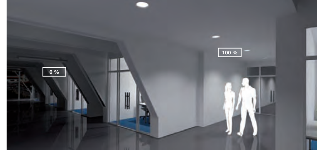
Wenn nur im ersten Bereich eine Bewegung wahrgenommen wird, werden nur die hier befindlichen Lampen eingeschaltet.
