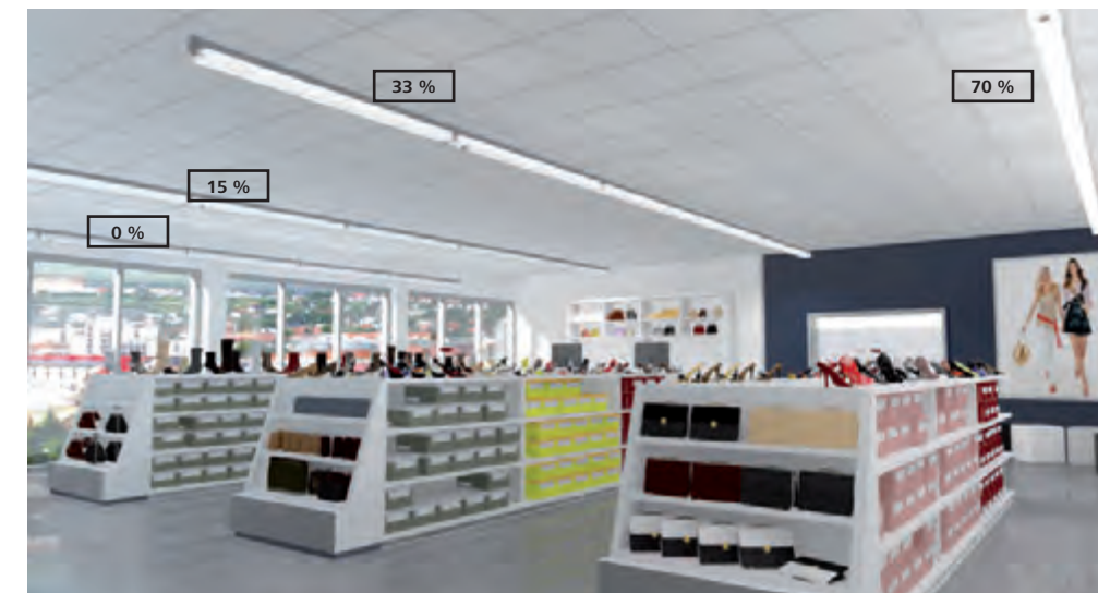
Falls der Raum große Fenster hat und bei Tag genug Licht einfällt, sollte man ein stufenförmiges Scanning einsetzen, um die Leuchten zu dimmen. Um eine gleichmäßige Beleuchtung im gesamten Raum beizubehalten, werden die Leuchten am Fenster automatisch weiter heruntergedimmt.
