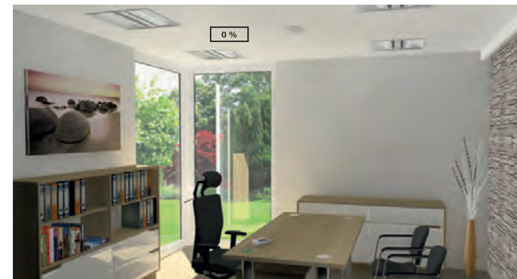
Wenn durch die Fenster genug Lichtintensität im Raum vorhanden ist, bleiben die Leuchten automatisch ausgeschaltet, auch wenn eine Bewegung wahrgenommen wird.
