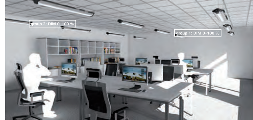
Während der normalen Arbeitszeit werden die Leuchten je nach einfallendem Tageslicht autonom gedimmt. Gleichzeitig schalten sich die Leuchten automatisch ein und aus, entweder aufgrund einer Bewegungserfassung oder aufgrund der Betätigung einer Drucktaste durch den Anwender.
