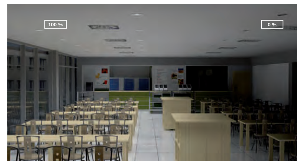
Die Gruppensteuerung ermöglicht ein Anschalten der Leuchten nur in dem benötigten Bereich.
