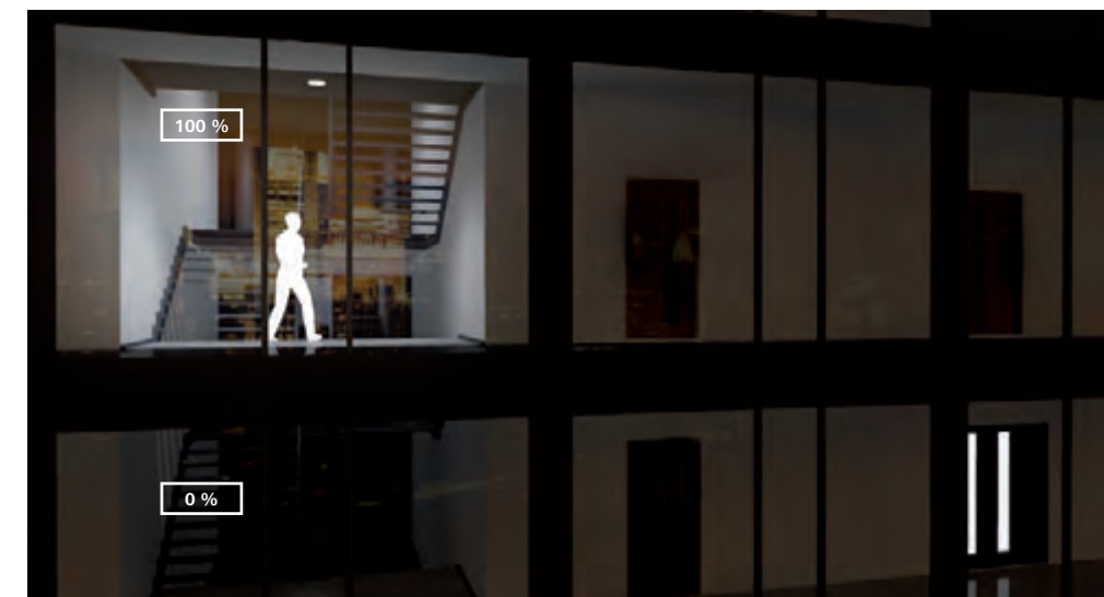
Sobald eine Bewegung über dem Erdgeschoss wahrgenommen wird, gehen alle Leuchten in dieser Gruppe an.
