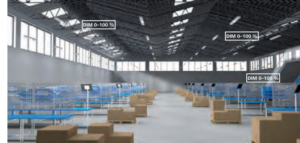
Steuerung, basierend auf Beleuchtungsintensität Die einzelnen Leuchtengruppen können unabhängig voneinander in den automatischen Modus gesetzt werden (Regulierung basierend auf der Lichtintensität) oder auf ein voreingestelltes Beleuchtungsszenario.
