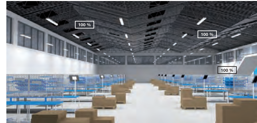
Wenn kein Tageslicht vorhanden ist, arbeiten die Leuchten mit voller Leistung.
