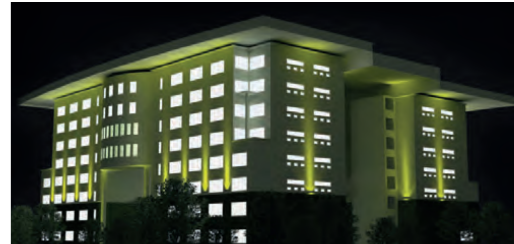
Das Gebäude wird von Lampen angestrahlt, die einen "Wallwashing"-Effekt an den Wänden hervorrufen. Die Überlagerung der Lichtfarben erfolgt nach einem voreingestellten Sequenzplan.
